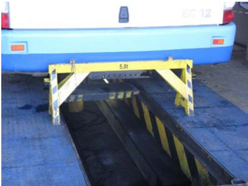
2. kép Az akna hossz tengelyére merőlegesen az autóbusz hátsó részénél elhelyezett 5,8 tonna névleges teherbírású fémből készült bak. (munkavédelmi hatóság felvétele)
