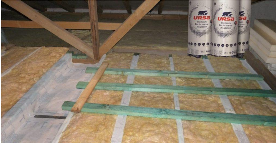
(1) Üveggyapot hőszigetelés pallók között
