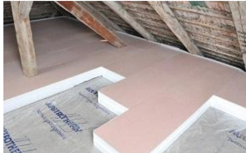
(2) Terhelhető EPS hőszigetelés faforgácslap járóréteggel
