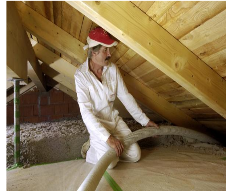
(3) Szórt cellulóz hőszigetelés
