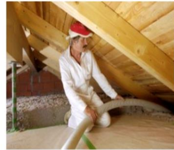
(3) Szórt cellulóz hőszigetelés
