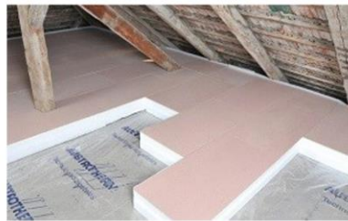
(2) Terhelhető EPS hőszigetelés faforgácslap járóréteggel
