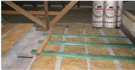
(1) Üvegyapot hőszigetelés pallók között
